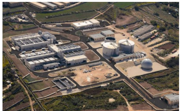
Vista aerea dell'impianto a fine lavori
