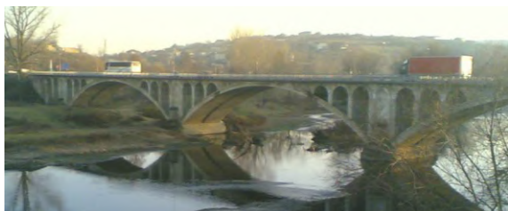
Vista prospettica del ponte prima dell'inizio dei lavori
